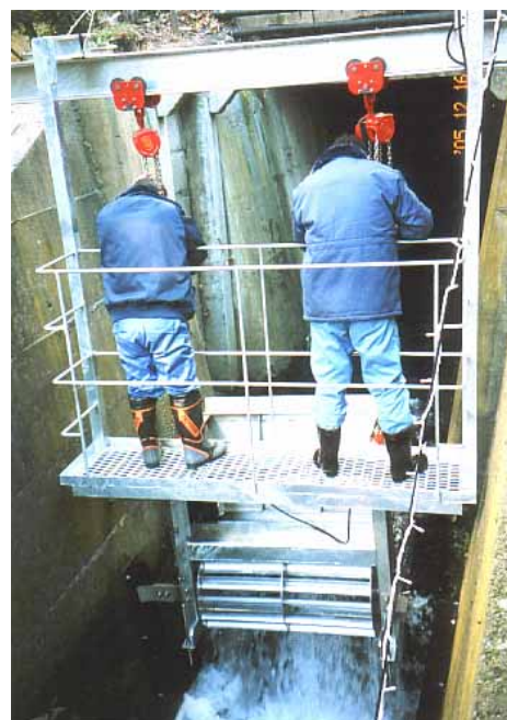
図2(a) 水車設置状況1
