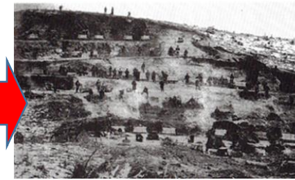
<段々に崩す作業現場>
