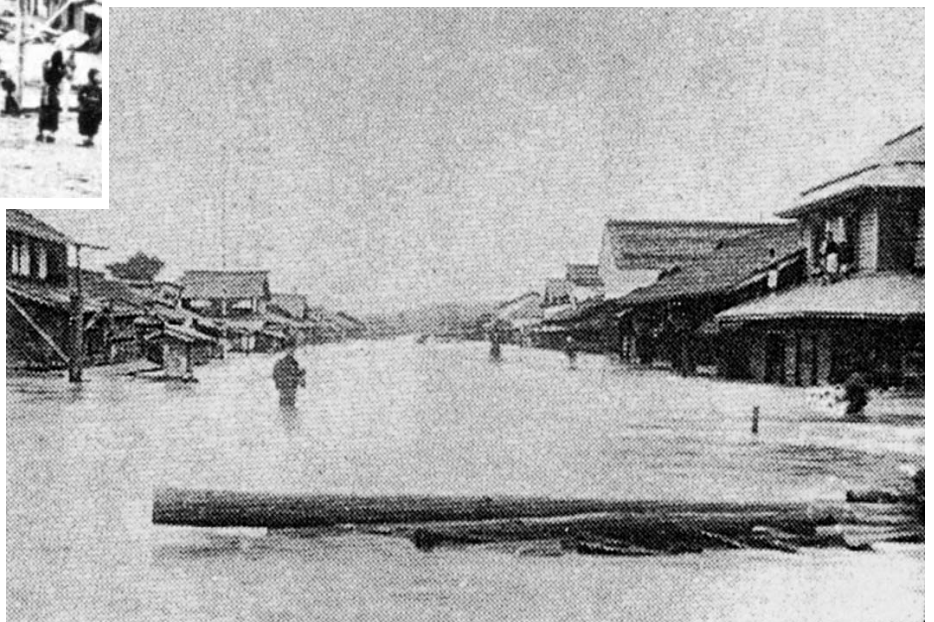
滝川市街地の浸水状況(滝川河川事務所史より)
