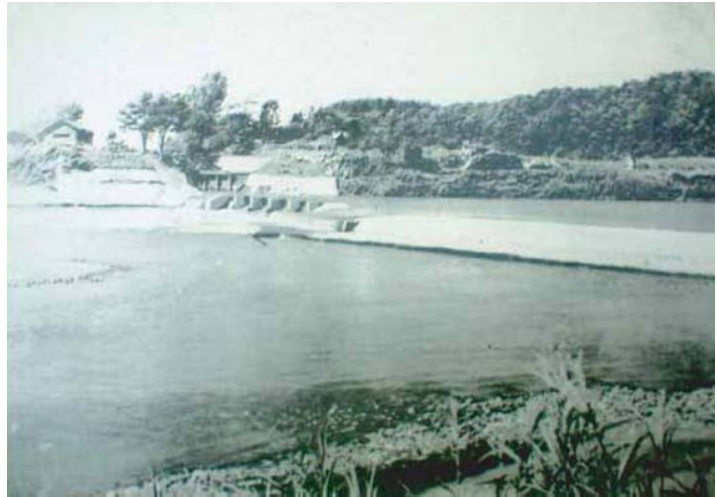
明治32年竣工の夕張川頭首工(昭和8年改良)
